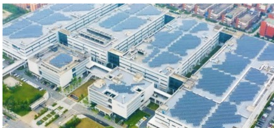
太阳能光伏系统
